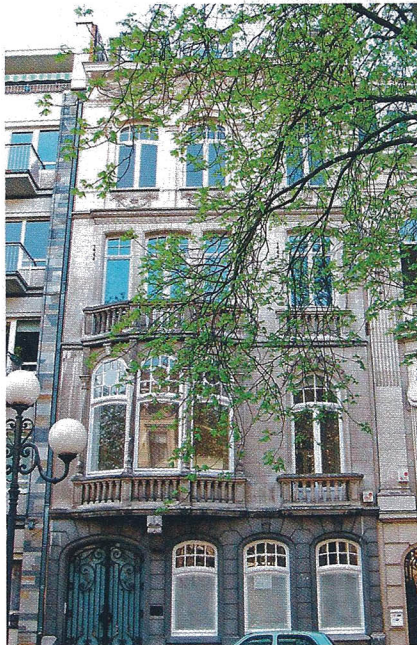
AVENUE LEPOUTRE À IXELLES Cette maison de maître de 600 m 2 était affichée à 2,475 millions d'euros, soit près de 5.000 euros le mètre carré frais compris.
